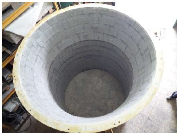
PARTICOLARE RIVESTIMENTO INTERNO TRAMOGGIA CENTRALE
