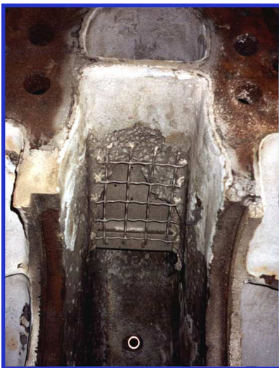
FASE: 3 APPLICAZIONE PASTA MOLECOLARE (PLASTICA)
